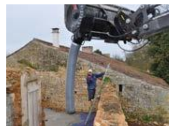
Abläßrohr 1,50 m (Option : 3 m)
